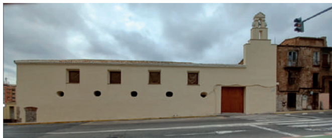
Figura 1. Fachada del edificio fundacional restaurada (2024) de la Real Fábrica de Loza y Porcelana de l'Alcora.
