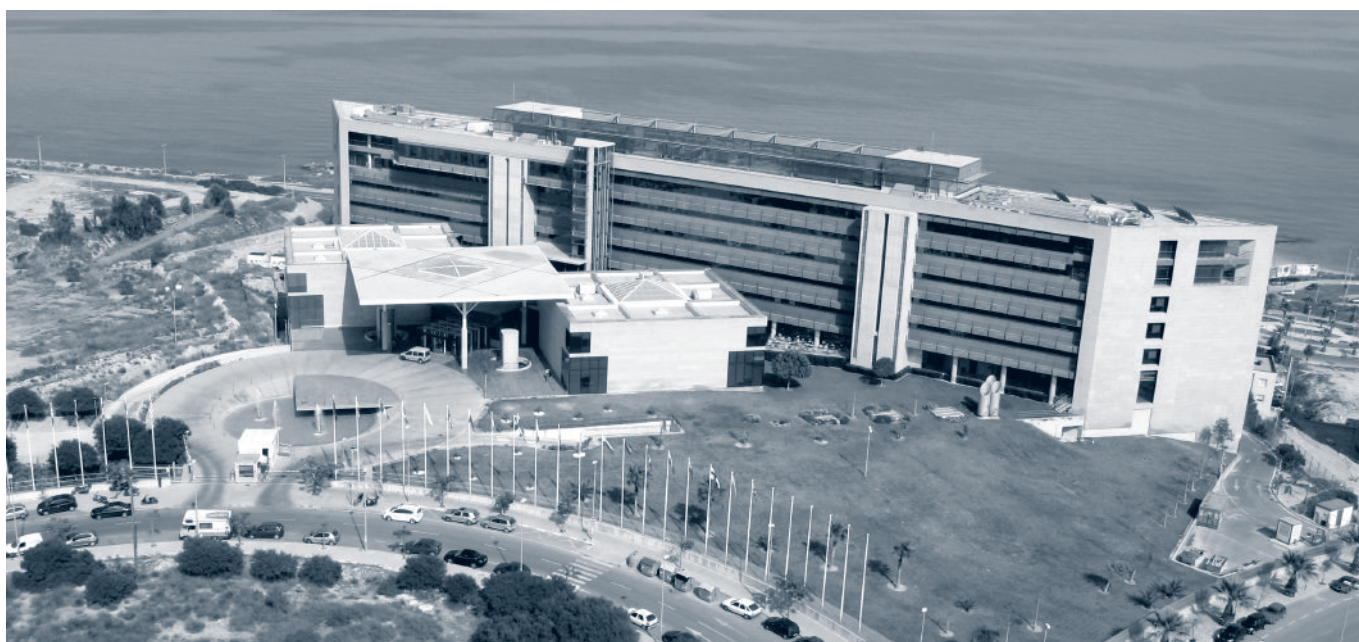
Figura 3. Sede de la OAMI, Oficina de Armonización del Mercado Interior de la UE, en Alicante.
