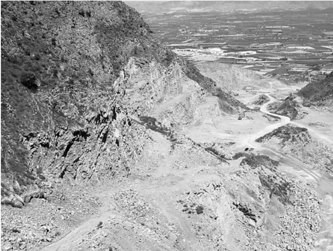
Figura 1. Zona de labores de una cantera de áridos en la Sierra de Callosa (Alicante)
