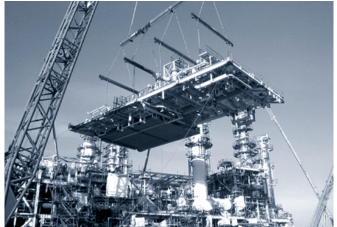
Montaje de un "pancake".
