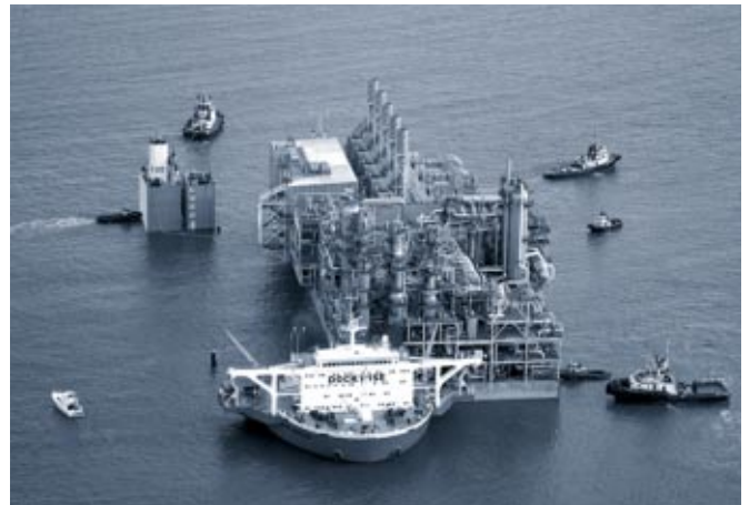
La planta siendo cargada encima del barco de transporte.
