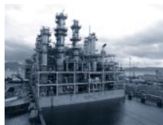
La planta durante la maniobra de encastre en la isla de Melkøya.
