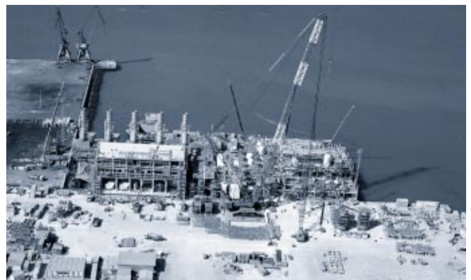
La segunda grúa mayor del mundo delante de la obra.
