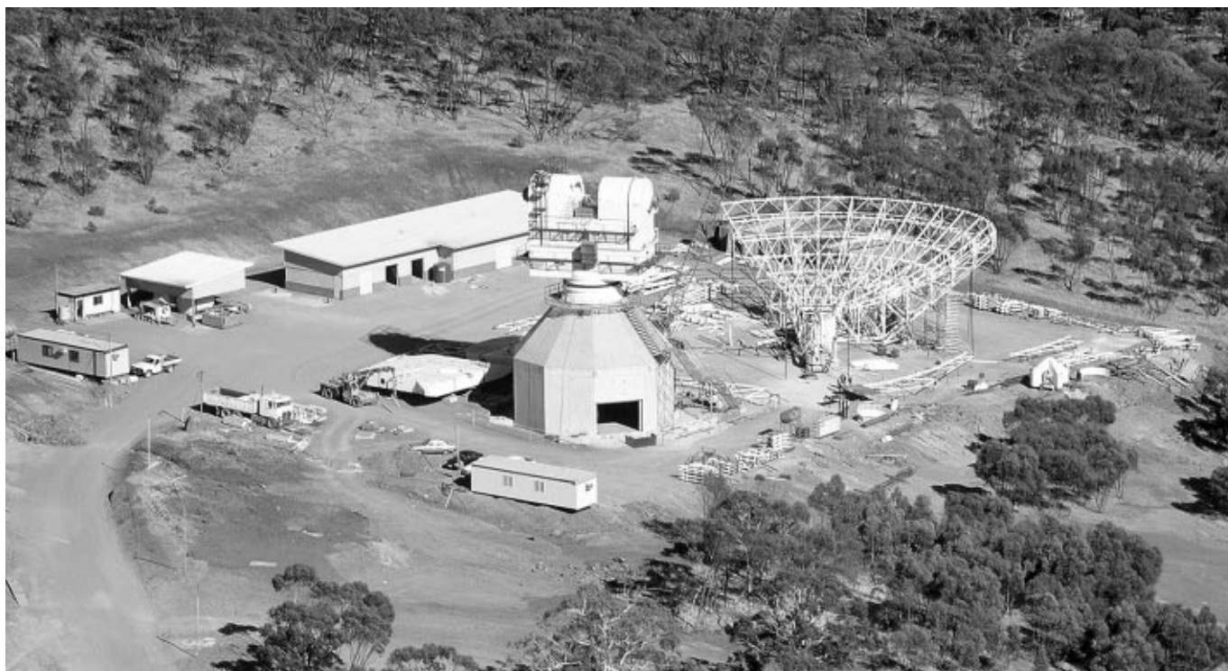
Construcción de la estación de espacio profundo en Nueva Norcia.
